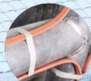
Обогрев водопроводов
