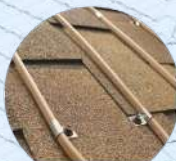
Обогрев кровли
