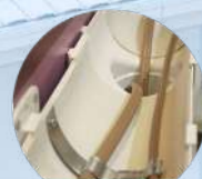
Обогрев водостоков
